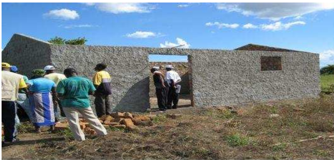
Foto 2: Armazem do clube de negócios de Machanga ainda em construção
